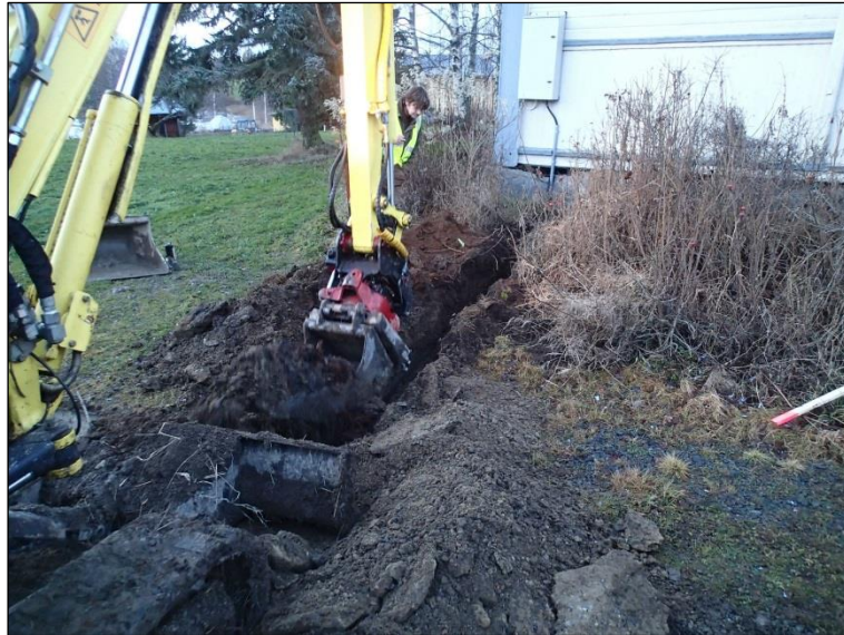
Kaapelikaivantoa Nisulan kupeessa, länteen.
