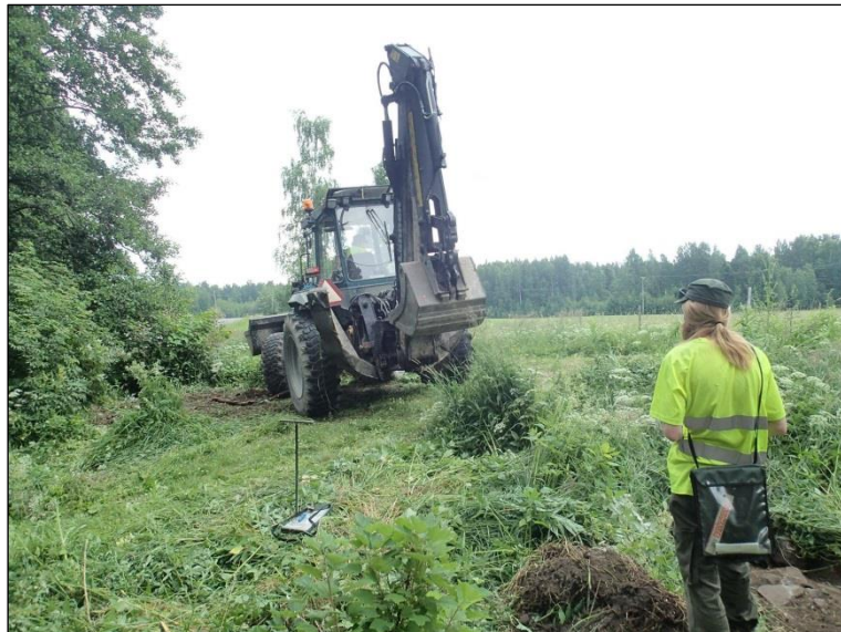
Sekoittuneita muokkaus- ja täyttökerroksia poistetaan kaivinkoneella.
