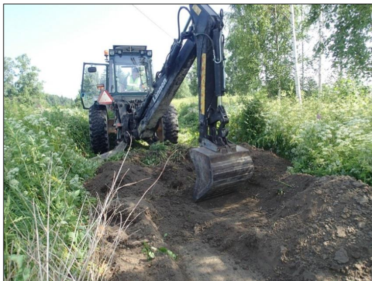
Sekoittuneita muokkaus- ja täyttökerroksia poistetaan kaivinkoneella.
